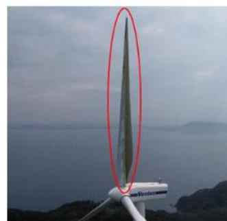
7号風車:ブレード1枚破損
