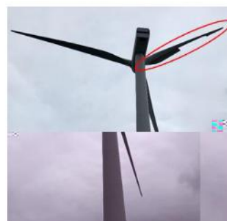
13号風車:ブレード1枚破損
