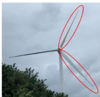
16号風車:ブレード2枚破損
